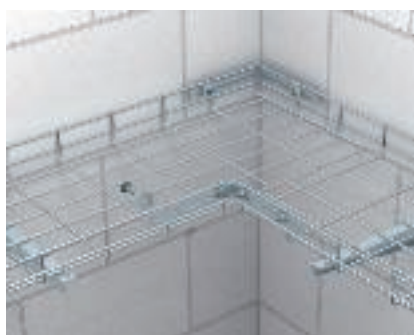
Réalisation d'un coude de chemins de câbles en treillis - angulaire Après la coupe appropriée des chemins de câbles en treillis, ces derniers peuvent être assemblés en un coude de chemin de câbles en treillis angulaire non chevauchant à l'aide des éclisses couvre-joints GSV 34 et d'un feuillard coudé.
