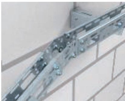
Éclissage vertical Eclissage linéaire vertical du canal AZ type LTS, à l'aide de deux éclisses droites/coudées type VF AZK.
