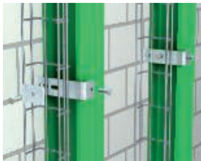
Application : crapautage sur poutre acier Montage vertical de chemins de câbles en treillis sur IPN, fixé avec une pièce de serrage de type BFK et une pièce de serrage de type GKS 50.
