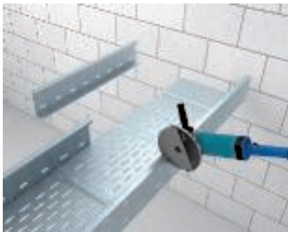
Réalisation d'un té de dérivation avec pièce d'angle à monter Séparation des ailes du chemin de câbles longue portée.
