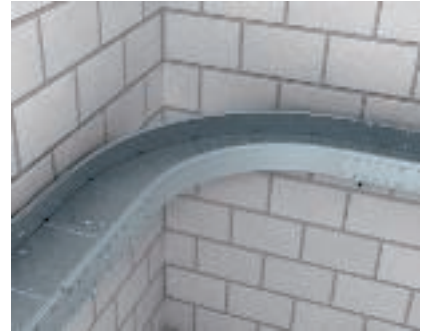
Montage d'un coude à 90° Coude en association avec les chemins de câbles longue portée. Le coude est relié à l'aide d'éclisses et de couvre-joints d'échelle à câbles longue portée.
