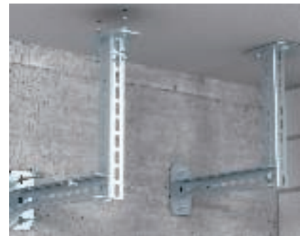
Construction spéciale Construction spéciale à l'aide de profilés en U pour le supportage d'un système de chemin de câbles
