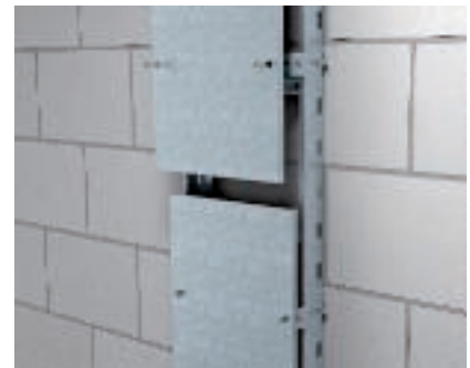
Montage vertical du couvercle Montage du couvercle avec entretoise sur une échelle verticale.
