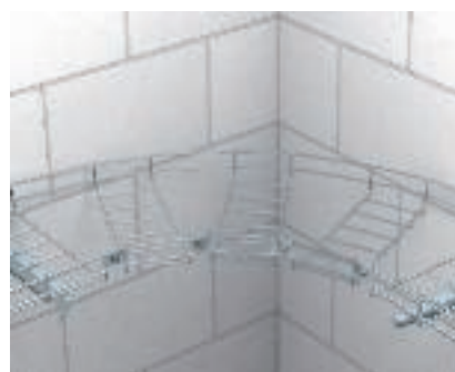
Réalisation d'un coude de chemins de câbles en treillis - rond En coupant une maille sur deux, il est possible de réaliser des coudes de chemins de câbles en treillis d'un rayon supérieur. La fixation s'effectue avec des éclisses d'angle GEV 36.
