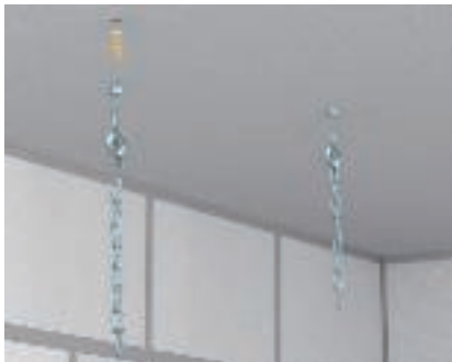
Montage d'une suspension par chaîne Suspension du canal AZ LTS par chaînette type LTK-K et crochet type 948/TG6.
