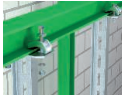
Construction suspendue sur poutres acier Construction suspendue adaptée au chemin de câbles longue portée avec montant IS 8, fixée sur une poutre métallique.
