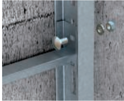
Fixation d'échelon d'angle Fixation de l'échelon d'angle WSK 40 dans une échelle verticale industrielle de type SLS 80.
