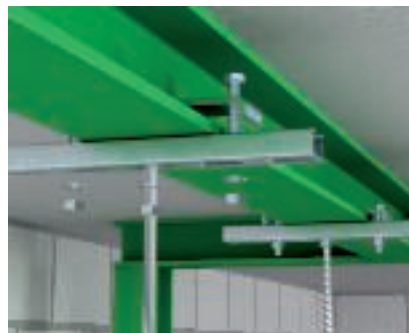
IPN rail profilé en C Fixation d'un profilé en C de type CPS 4 G ou CPS 5 G sur une poutre métallique à l'aide de crapauds de serrage KWS.
