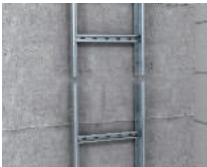
Éclissage d'échelles verticales Eclissage d'échelles verticales de type LG et SSL 60 avec une éclisse de type LVG.
