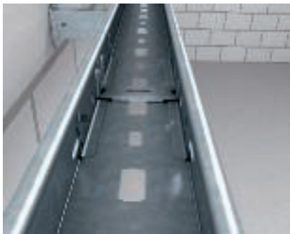
Éclissage linéaire pour chemin de câbles support pour luminaires Eclissage linéaire pour chemin de câbles support pour luminaires type LTR avec le kit d'éclissage type RV 607.
