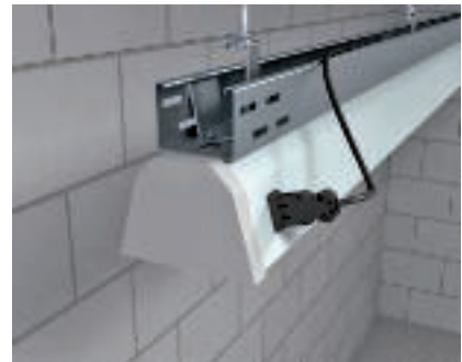
Support de luminaires préconfectionné Montage d'une lampe préconfectionnée sous un canal support de luminaires.
