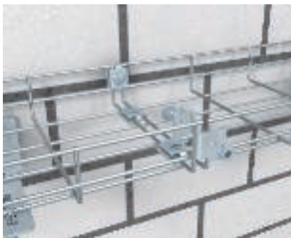
Éclissage vissé de chemins de câbles en treillis Réalisation d'un éclissage vissé de chemins de câbles en treillis avec éclisses / contre éclisses GSV 34.
