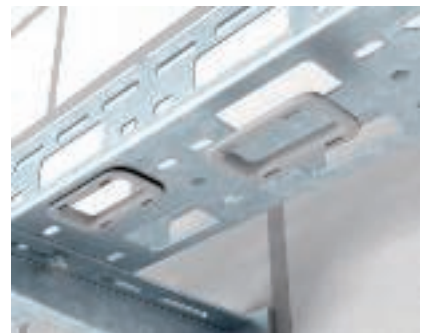
Montage d'une bague de protection pour câble (fond) Montage des bagues de protection type KSR 915 au fond du canal AZ LTS.
