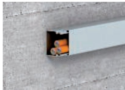
Pose nette et propre de câbles de détection d'incendie et de données en goulotte type 20030
