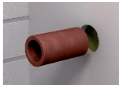
Insérer la gaine tubulaire dans une cloison légère
