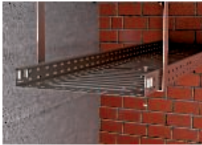
Fixation des chemins de câbles au moyen de boulons TRCC
