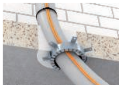
Installation du tube ultérieure avec 2 câbles de tirage
