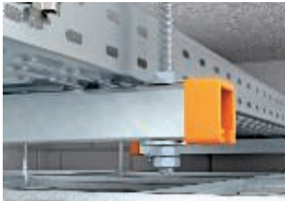
Fixation par serrage pour une capacité de charge élevée
