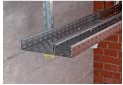
Montage de 2 chemins de câbles sur une même console
