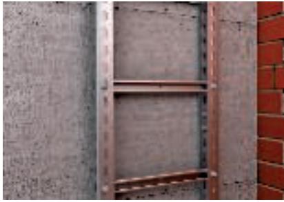
Montage direct de la remontée verticale sur mur massif
