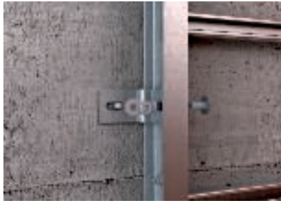
Montage avec équerres de fixation vissées
