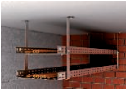
Montage biniveau au plafond à l'aide d'un étrier de suspension et rallonge
