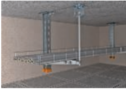
Suspension de plafond mononiveau
