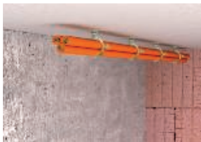
Pose de faisceau de câbles en plafond
