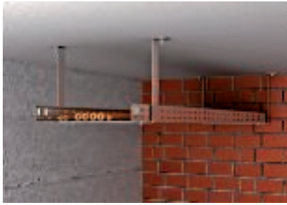
Montage mononiveau au plafond à l'aide d'un étrier de suspension
