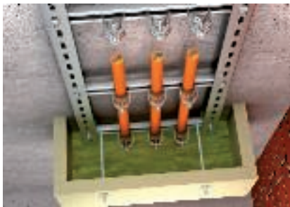
Mesures de support efficaces avec la décharge de traction ZSE90
