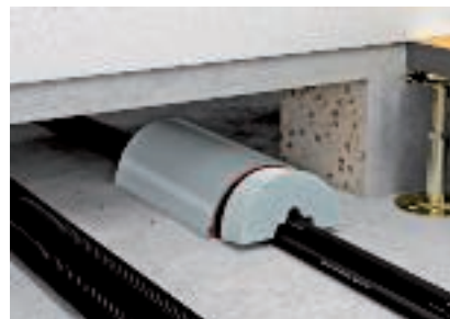
Ajuster les bouchons en mousse aux câbles
