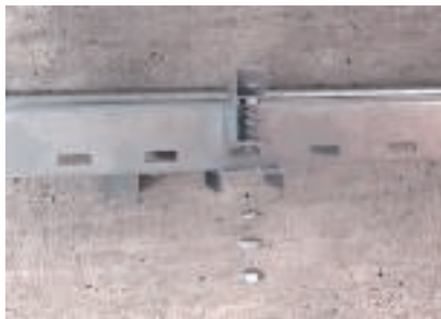
Montage oblique du raccord au moyen de vis et d'écrous hexagonaux
