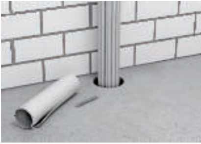
Préparation du calfeutrement de câbles
