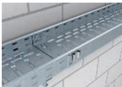
Éclissage couvre-joint caché, seule la patte inférieure est à plier
