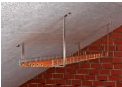
Montage sous plafond incliné avec étrier de suspension adapté au cas par cas
