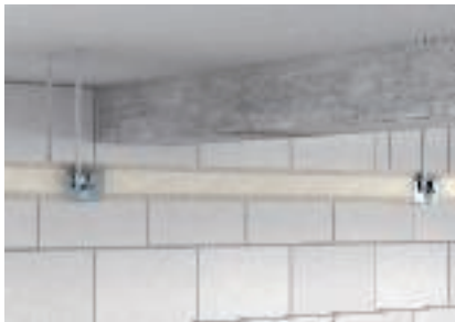
Montage suspendu par les éclisses
