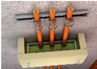
Montage de décharge de traction associée à une pose sur rails profilés
