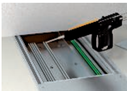
Application de la mousse coupe-feu directement sous le mur
