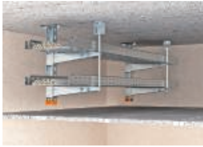
Suspension de plafond biniveau avec disposition des consoles d'un seul côté
