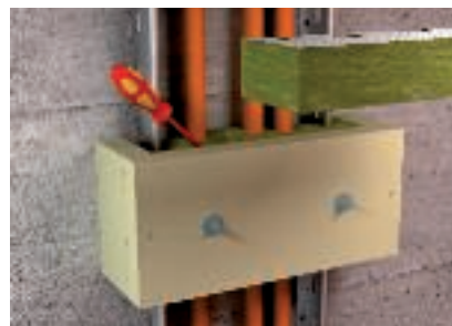
Remplissage en laine de roche pour garnissage de câbles flexible
