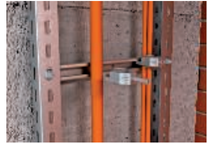
Installation des câbles avec brides de fixation, également possible avec garnissage multiple
