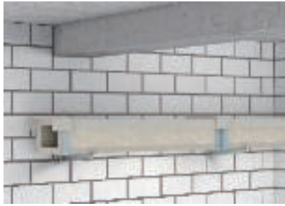
Montage mural sur supports
