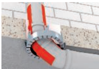
Manchons dans la zone de passage
