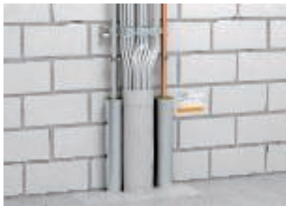
Installation du bandage coupe-feu avec écart zéro par rapport au calfeutrement de tube Rockwool Conlit
