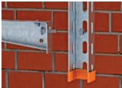
Montage de console sur pendard avec boulon TRCC
