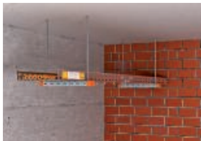
Suspension de plafond mononiveau
