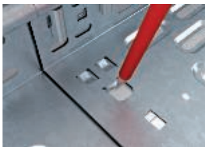
Éclissage couvre-joint sans vis, il suffit de plier les pattes inférieures
