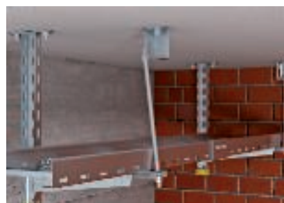
Suspension de la tige filetée dans les étriers résistants au feu
