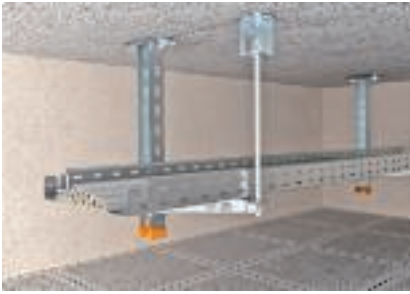
Suspension de plafond mononiveau
