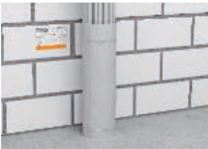
Obturation de l'ouverture résiduelle du calfeutrement avec du mortier et montage de la plaque d'identification
