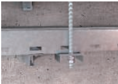
Fixation de la tige filetée verticale sur le raccord
