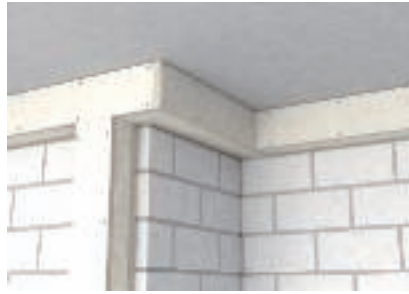
Souplesse dans le cheminement grâce à une matière façonnable à la scie
