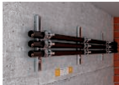
Installation peu encombrante de plusieurs tubes les uns à côté des autres avec brides de fixation
