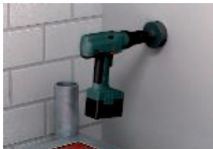
Carotter le mur avec une scie cloche
