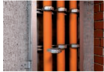
Installation de câbles avec brides de fixation sur échelons d'échelles verticales
