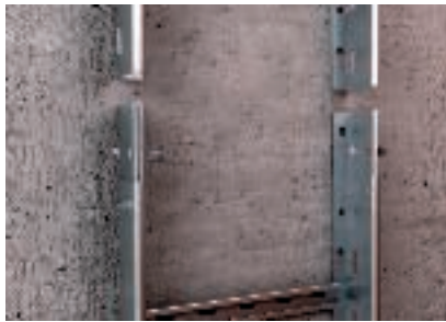
Éclissage couvre-joint avec éclisse à vis
