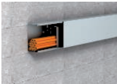
Pose de câbles de puissance, de détection d'incendie et de données en goulotte type LKM60100
