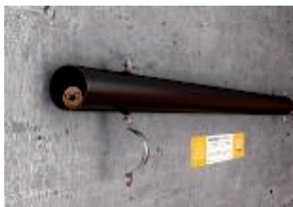
Pose dans le collier d'écartement à vis par accrochage du couvercle en dessous de la vis
