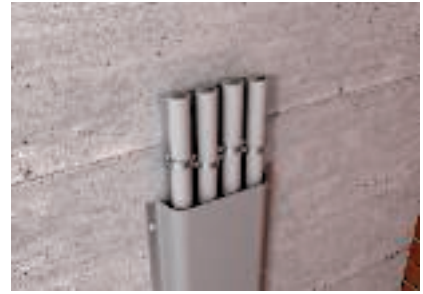
Fixation de l'enrubannage sur rails métalliques pour câbles fixés par clip individuel
