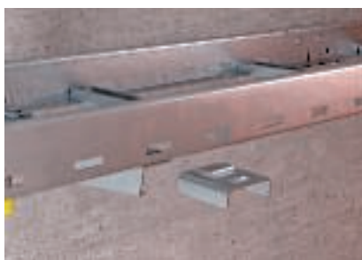
Emboîter le raccord sur la membrure inférieure du longeron d'échelle
