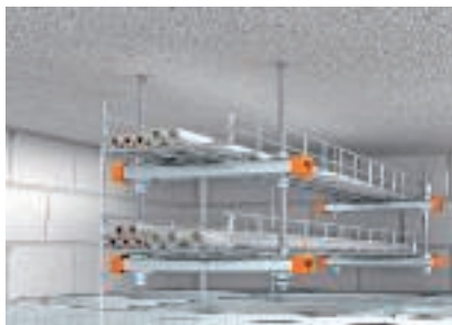
Montage biniveau au plafond au-dessus d'un faux plafond coupe-feu
