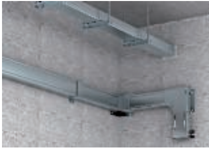
Montage direct au mur et suspendu au plafond
