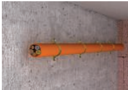
Montage mural horizontal des câbles
