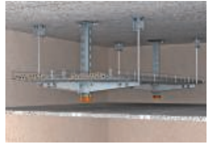
Suspension de plafond biniveau avec disposition des consoles de chaque côté
