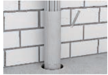
Fixation du bandage avec fil de bobinage
